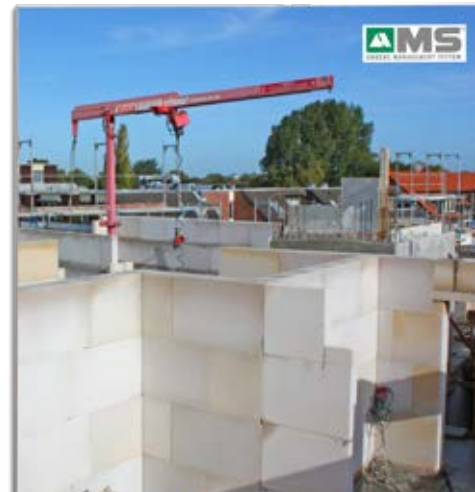
Montageanweisung für Kalksandstein-Planelemente
