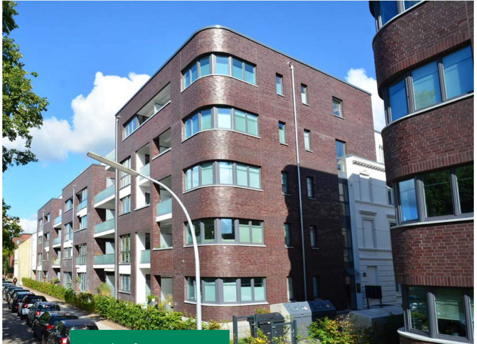
Josephstraße 2022 Schlüsselfertiger Wohnungsbau in zwei Bauabschnitten in Hamburg-Wandsbek, 79 WE
